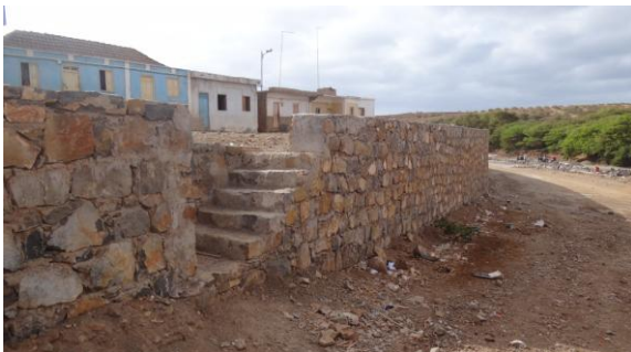
Murro de protecção da Figueira reconstruído
