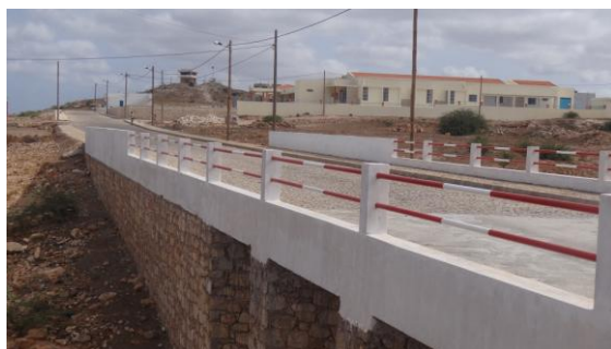
Ponte que dá acesso ao novo Centro de Saúde
