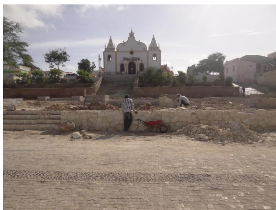
Fig. 2 – Arranque das obras na Praça Central
