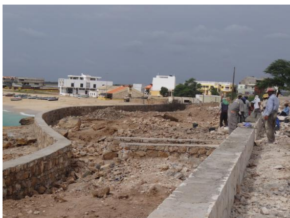
Fig. 1-Arranque das obras no parapeito da Av. Amílcar Cabral
