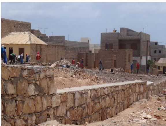
Fig.7-Trabalhos para drenagem de água na ribeira de Fontona (Cidade Inglês)
