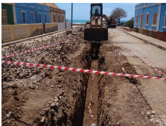
Fig.3 – Obras de rede de esgotos na Calheta
